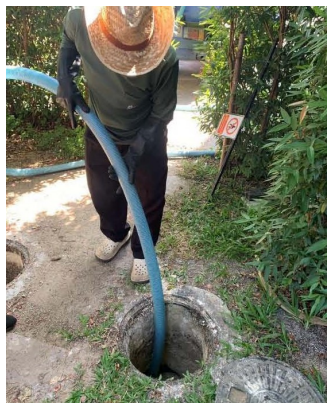
ภาพที่ 3-10 สูดตะกอนไขมันออกจากถังแยกตะกอน
