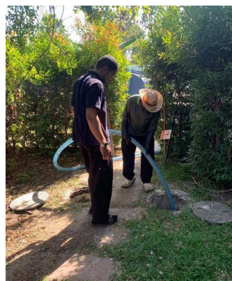
ภาพที่ 3-10 สูดตะกอนไขมันออกจากถังแยกตะกอน
