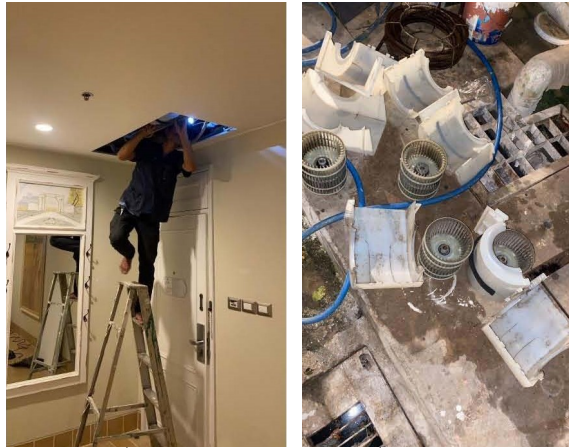
ภาพที่ 3-41 ล้างทำความสะอาดเครื่องปรับอากาศ
