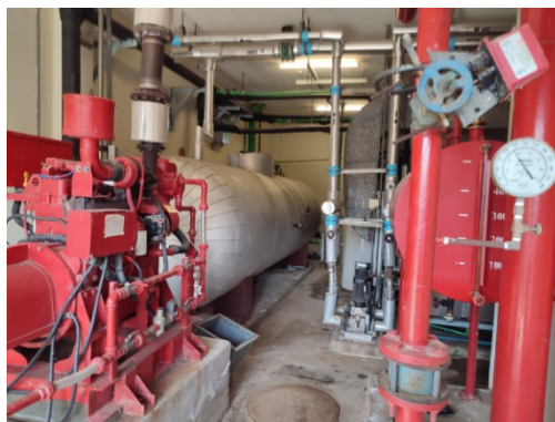
ภาพที่ 3-25 ห้องเครื่องสูบน้ำดับเพลิง ดูแลตรวจสอบไว้แล้วและเปลี่ยนอุปกรณ์ปัจจุบันอยู่ในสภาพดีพร้อมใช้งาน
