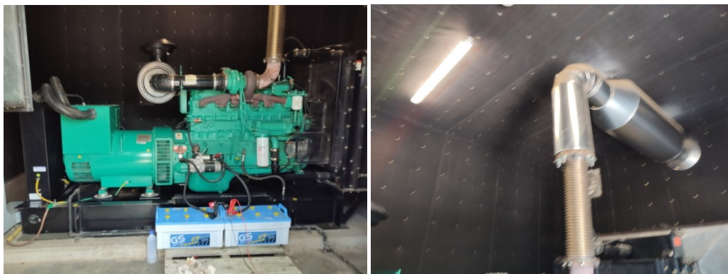
ภาพที่ 3-32 เครื่องกำเนิดไฟฟ้าฉุกเฉิน มีฉนวนกันเสียงตั้งอยู่ภายในห้อง
