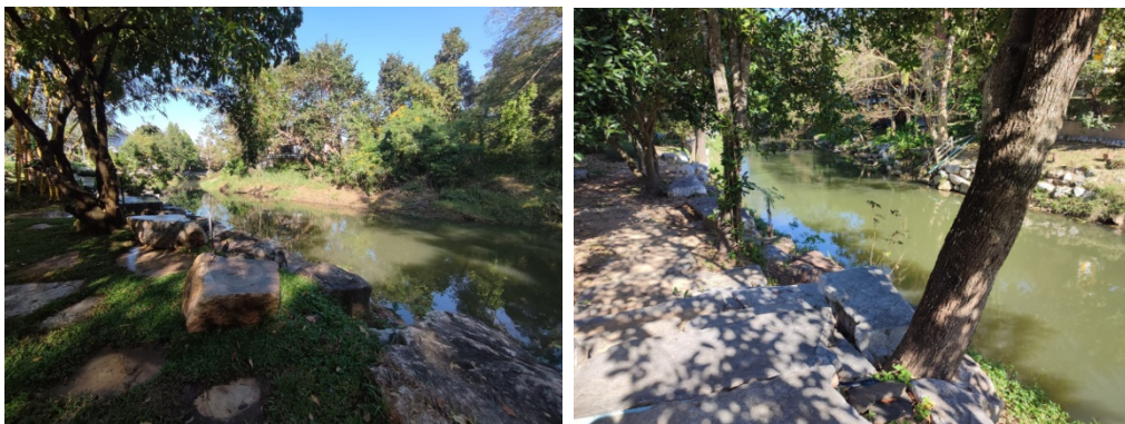
ภาพที่ 3-2 กำแพงดินเป็นภูเขารวมชาติ ใช้หินอ่อนตัดก้อน ทำเป็นกำแพงดินมีความลาดเอียงไม่เกิน 45 องศา และบ่อพักน้ำก่อนระบายออก
